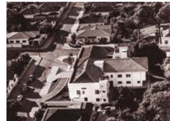
(2) Hospital São Judas Tadeu, inaugurado em 24 de março de 1962, na rua 20, esquina da avenida 31, no centro de Barretos/SP.
