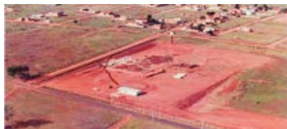
(11) Primeira etapa da construção do Hospital de Câncer de Barretos, no início dos anos 1990, quando o bairro ao entorno era pouco povoado.
